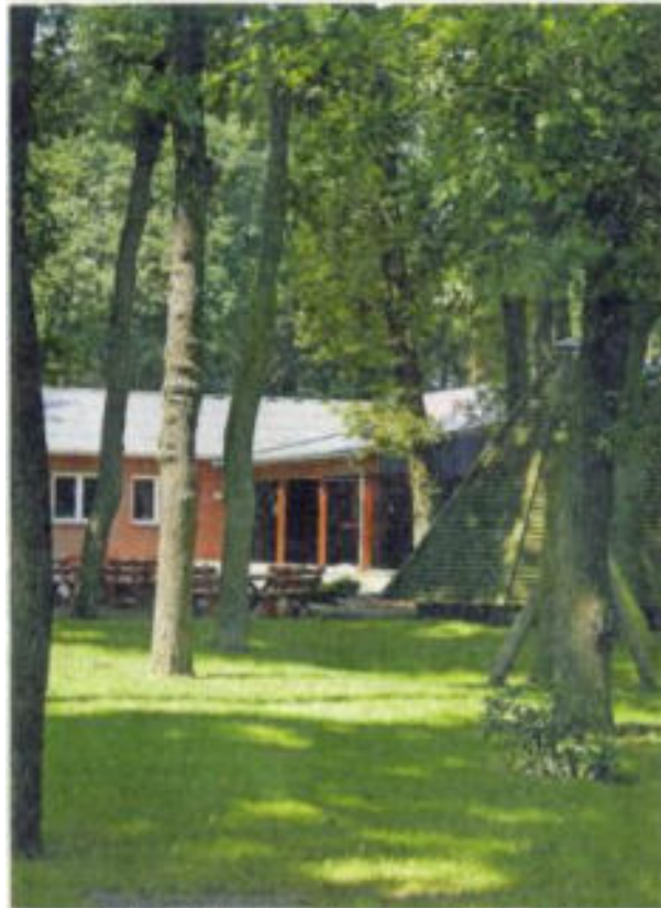
Eines der Ankerprojekte in der Dorferneuerung „Selsingen Süd“: Das mitten im Grünen gelegene Rockstedter Dorfgemeinschaftshaus „im Löh“ mit Außenanlagen. Foto Hilken
