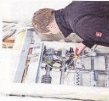
Für den Dorfladen ist eine neue Elektrik installiert worden.
